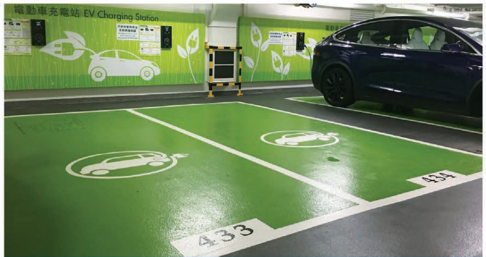
EV Charging Station 電動車充電站
